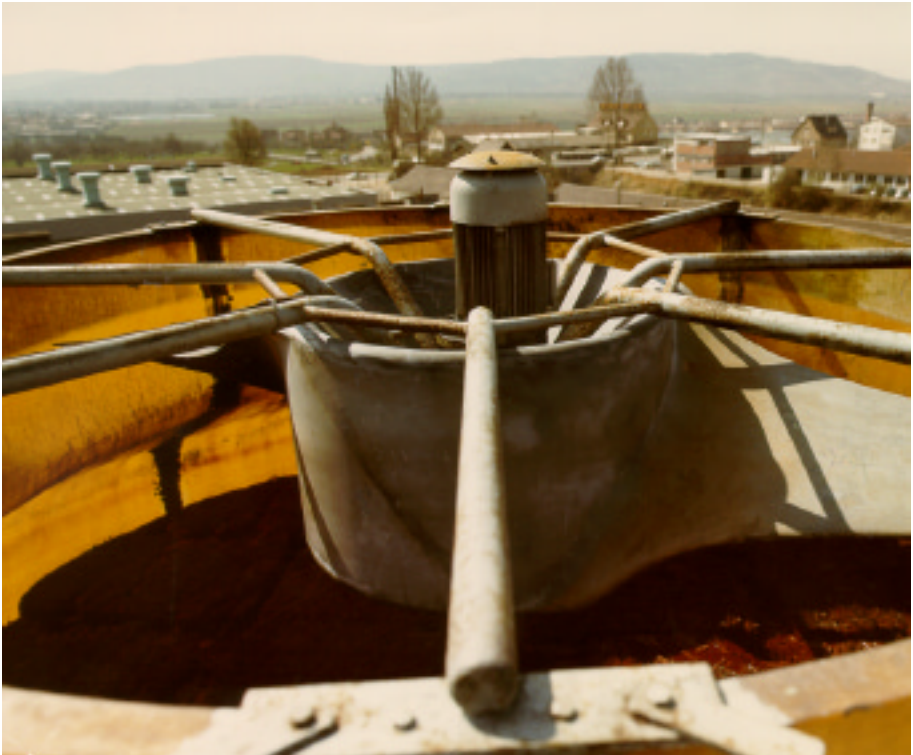
Bild 29 Getriebemotor in Aufstellung V1 zum Antrieb eines Kühlturmventilators Lüfterrad-Durchmesser bis zu 3,5 m typische Trägheitsfaktoren FI bis zu 30
