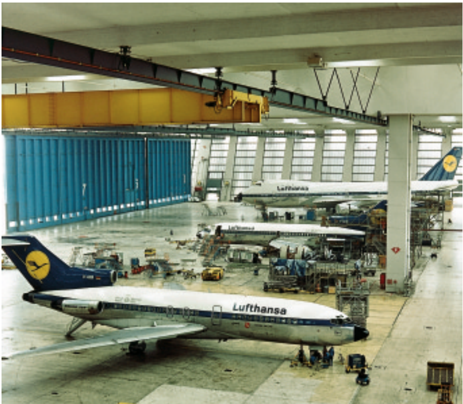
Bild 2.4.4 Hallenkran zur Wartung von Verkehrsflugzeugen. Besondere Anforderungen an sanftes Anfahren und Bremsen der Kranfahrbetriebe.
