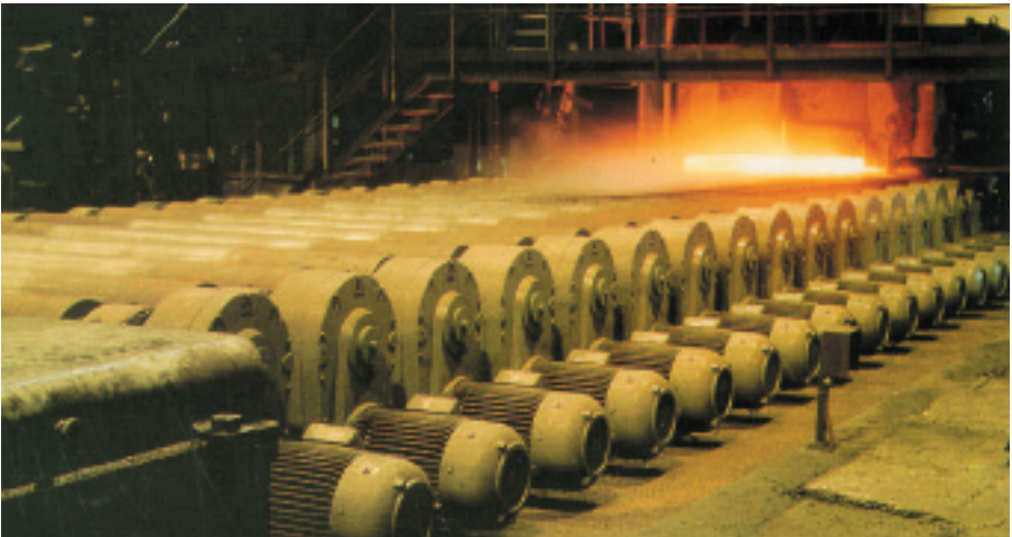
Bild 16.3.3 Anwendungsbeispiel von Rollgangs-Getriebemotoren mit überwiegender Beschleunigungsarbeit an einem Arbeitsrollgang
