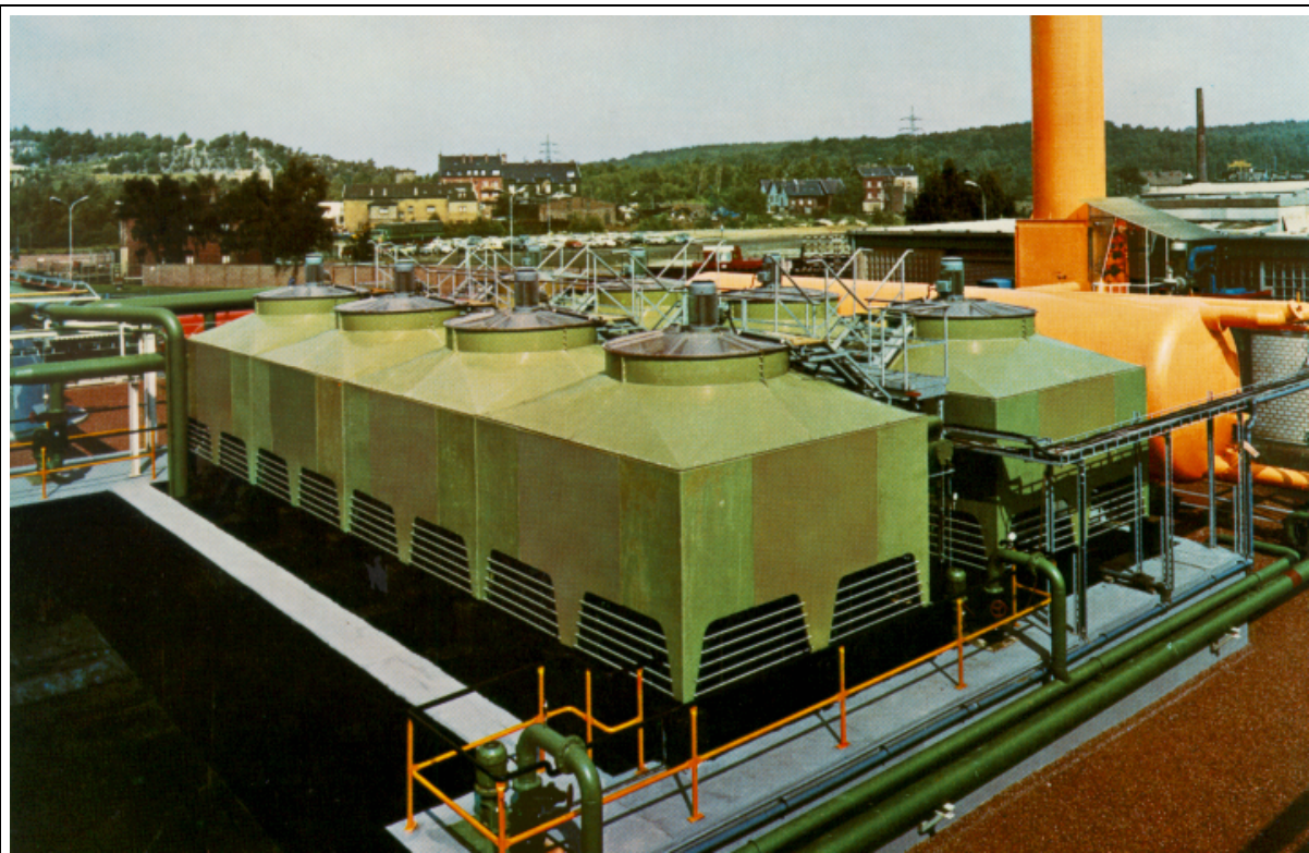
Kühltürme in Gruppenbauweise bei den Vereinigten Glaswerken in Stolberg GEA - Luftkühler GmbH)
