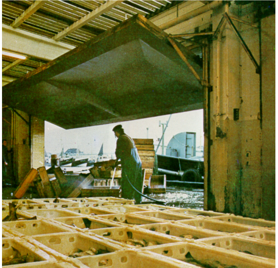
Bild 26.23 Antrieb für Kipptor in einer Fischauktionshalle mit stark salzhaltiger Atmosphäre.
