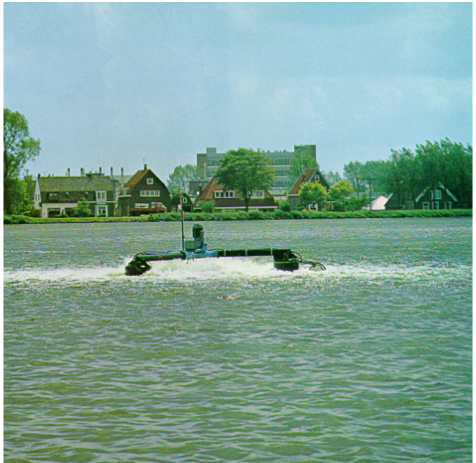
Bild 26.10 Drehstrom-Flachgetriebe- Motor als Rührwerksantrieb an einer Wasser- Umwälzanlage in einem Hafenbecken.
