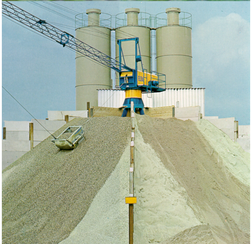
Bild 26.11 Drehstrom-Flachgetriebe- Motor an einem Großschrapper auf einer Beton-Mischanlage.
