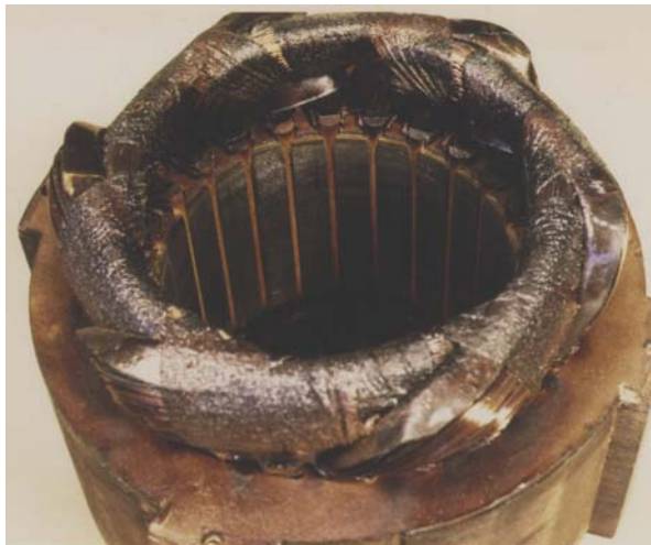
Bild 6.6 Starke Bräunung und Alterung der Isolierstoffe nach starker und langdauernder Überlastung
